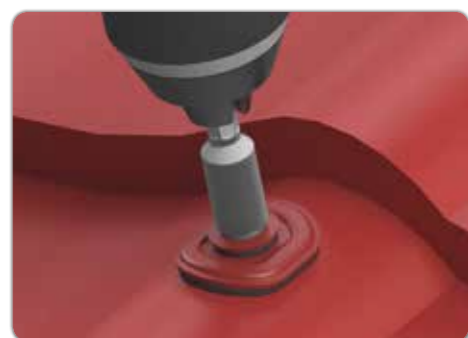
3. Anziehen bis Dichtung leicht komprimiert
